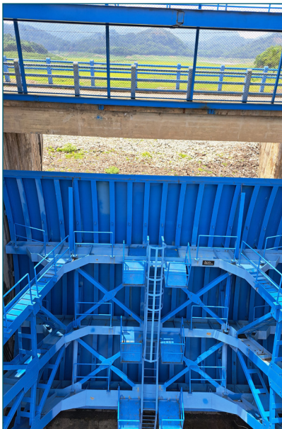
a. Ubrug spillway gate
